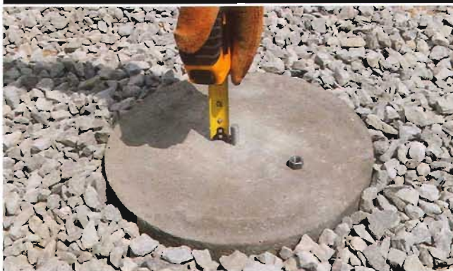
ВЫРАВНИВАНИЕ ШПИЛЬКИ
