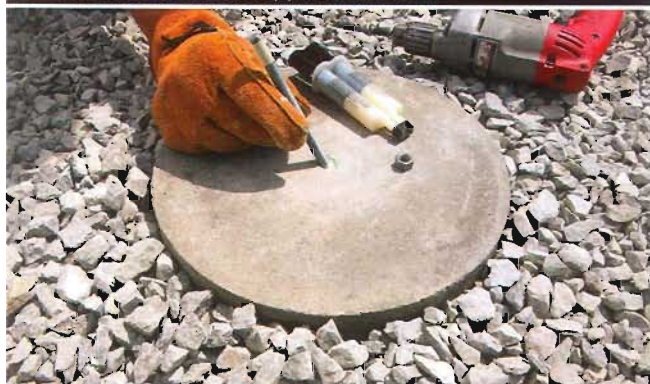
СВЕРЛЕНИЕ И ЭПОКСИДНАЯ СМОЛА
